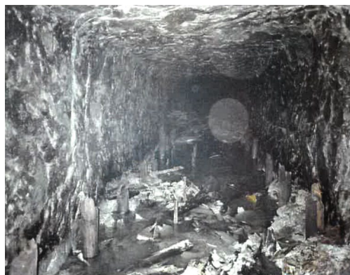
㉓ 第2坑道の測点No.5～No.6付近。坑道は当時のまま残る。両側には支保工が整然と残る。
