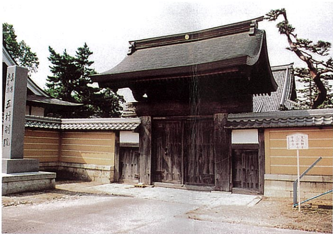
■表門（重要文化財） 延宝2年（1674）建立。大工は西嶋家。
