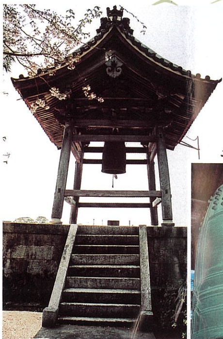
しょうろう ■鐘楼（町指定文化財） 桁行一間 梁間一間 切妻造 棧瓦葺 梵鐘が改鑄された18世紀中期に建立、 大工は西嶋家。
